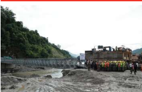
बेली पुल जडान तथा निर्माण
